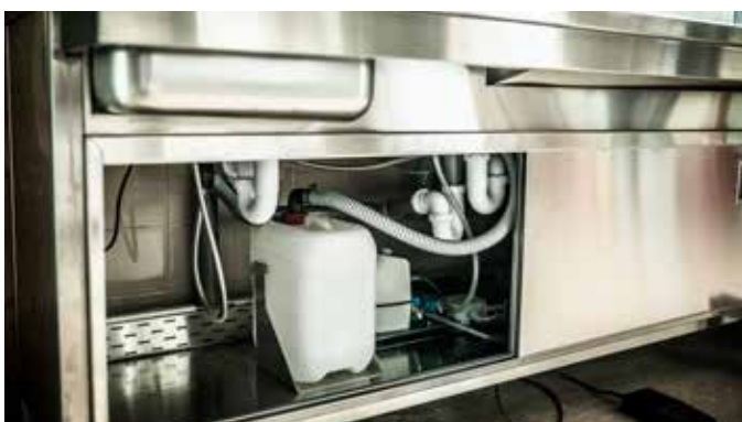
Recogida de formol con alarma de nivel
