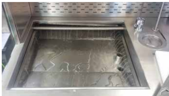
Lavado continuo bajo paneles perforados
